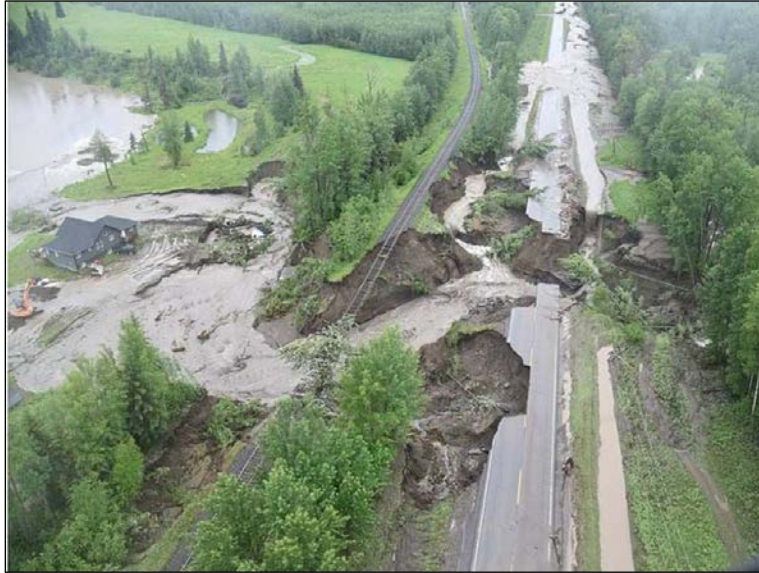
Figure 8 – Route et voie ferrée emportées par les eaux, Peace River Country en C.-B., 2016 (Ministère des Transports et de l'Infrastructure de la C.-B.)
