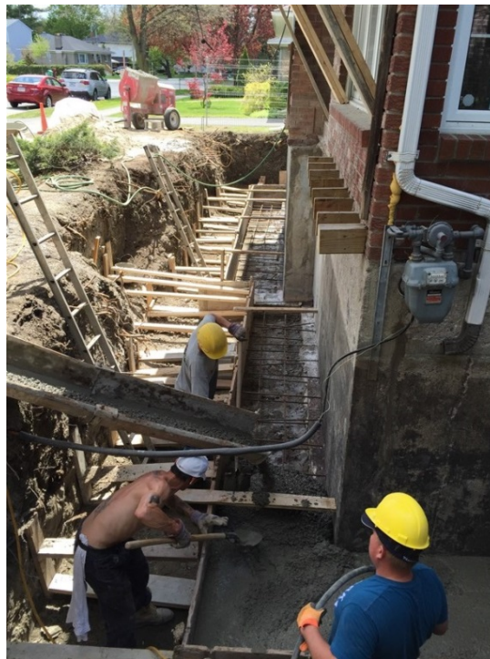
Figure 4 – Dommages aux fondations causés par des conditions de sol sec à Ottawa, 2016 (Photo de T. Manning)
