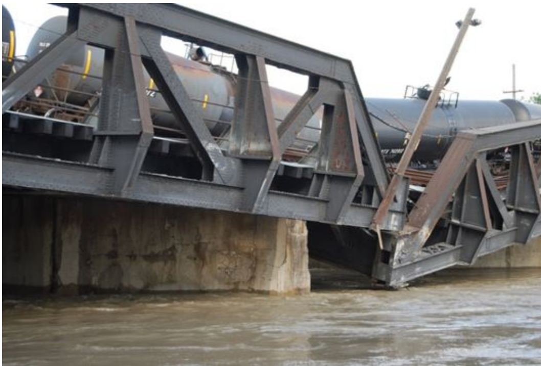
Figure 6 – Effondrement du pont Bonnybrook à Calgary, en Alberta, 2013 (Bureau de la sécurité des transports du Canada)
