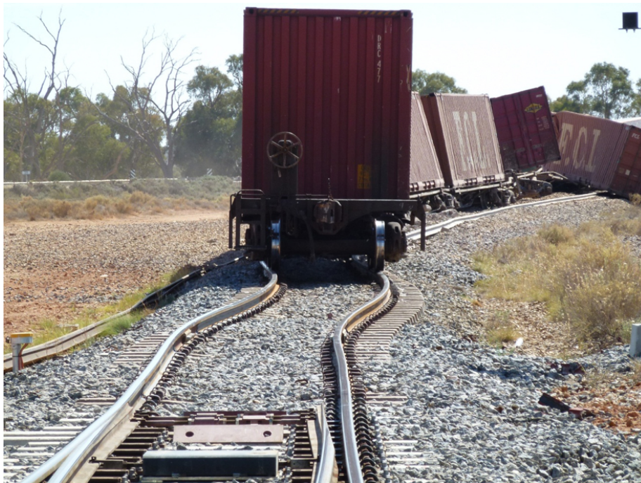
Figure 11 – Rails déformés par une vague de chaleur en Australie, 2013 (Australian Transportation Safety Board)
