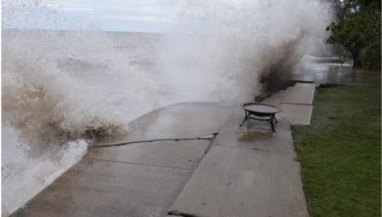
Figure 17. Impact, remontée et débordement de la vague à Stoney Creek, lac Ontario (photo : M. Davies).
