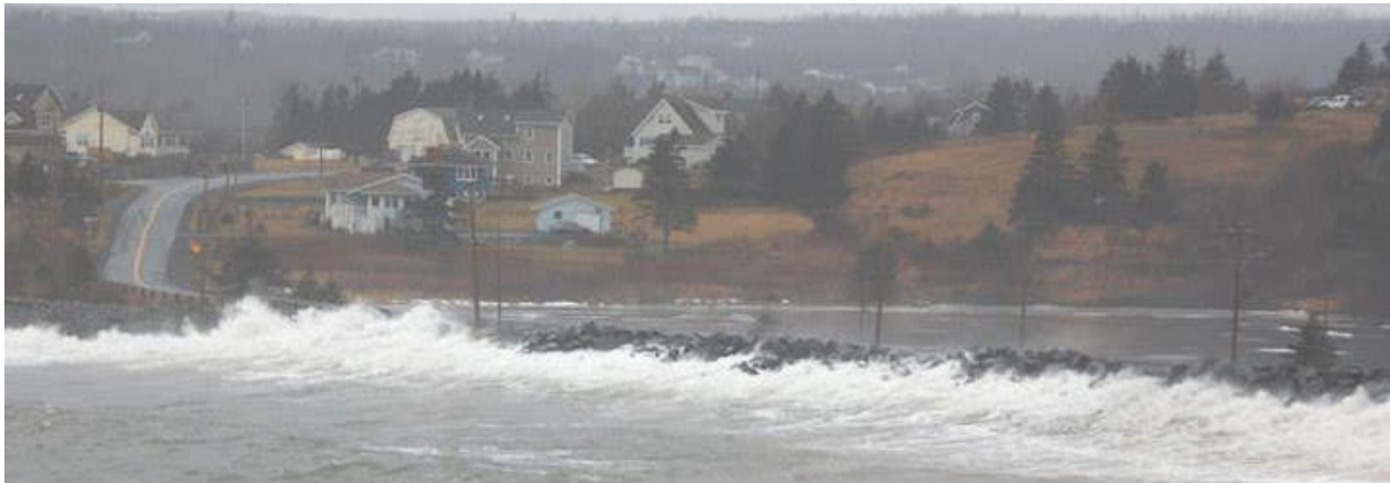
Figure 16. Vagues de tempête débordant de la route en remblai à Cow Bay, Halifax, Nouvelle-Écosse (photo : M. Davies).
