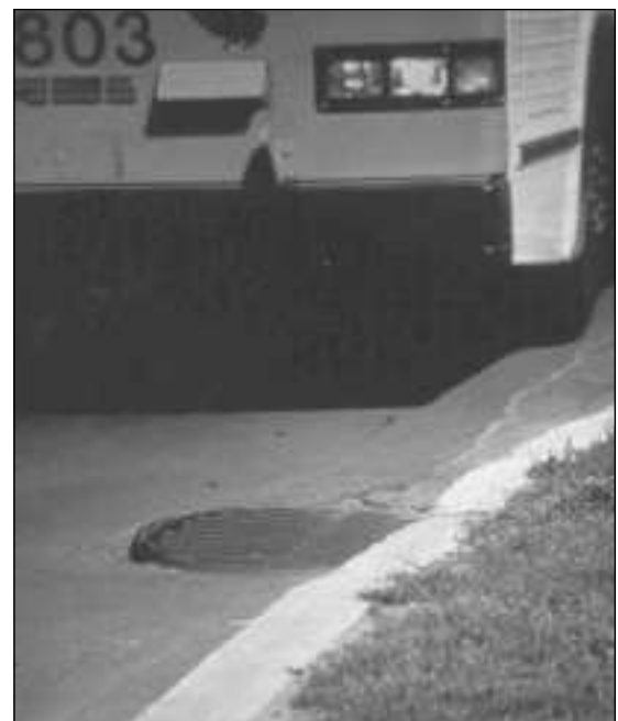
Figure 2. Un autobus ou un camion qui passe sur une irrégularité de la chaussée produit des vibrations.
