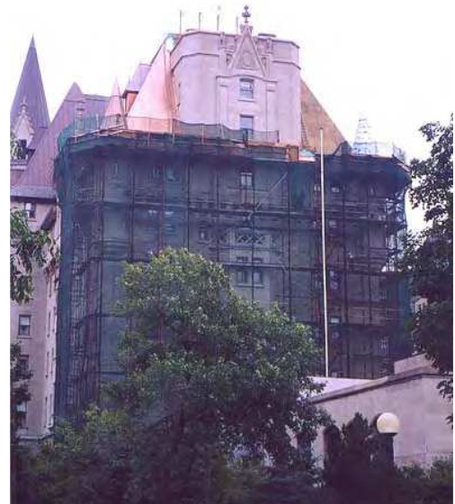
Figure 6 L'échafaudage doit protéger le mortier de rejointoiment frais de l'ensoleillement direct.
