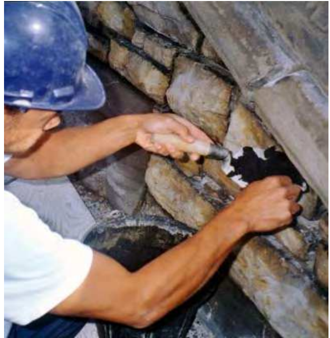
Figure 7 Le maçon au travail devrait être qualifié en conservation de maçonneries anciennes.
