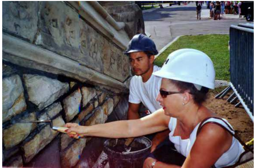
Figure 12 Inspection et discussion des techniques de façonnage du joint pendant l'essai de référence.
