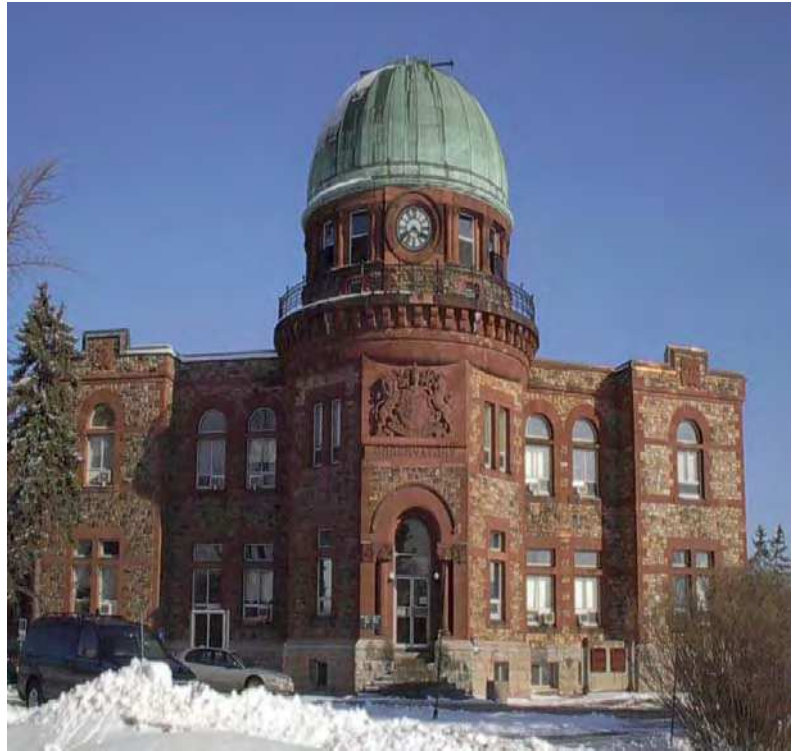
Figure 1 Construit en 1902 pour servir de principal point de référence longitudinal du Canada et déterminer et transmettre l'heure aux organismes gouvernementaux (une fonction qu'il a remplie de 1905 à 1970), l'Observatoire fédéral d'Ottawa est aujourd'hui classé monument historique. Revêtu de grès de Nepean et de Credit Valley, il a été rejointoyé en 2003-2004.
