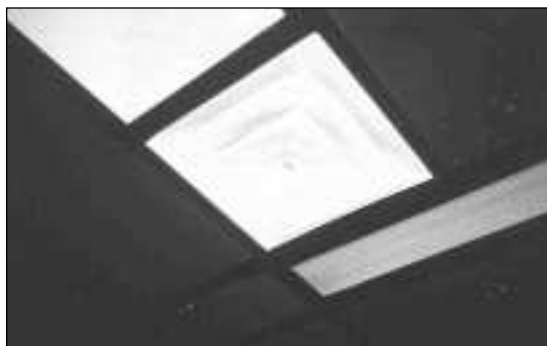
Figure 2. Mise à l'essai de deux types de diffuseurs : luminaires-reprises d'air et diffuseurs plafonniers carrés.
