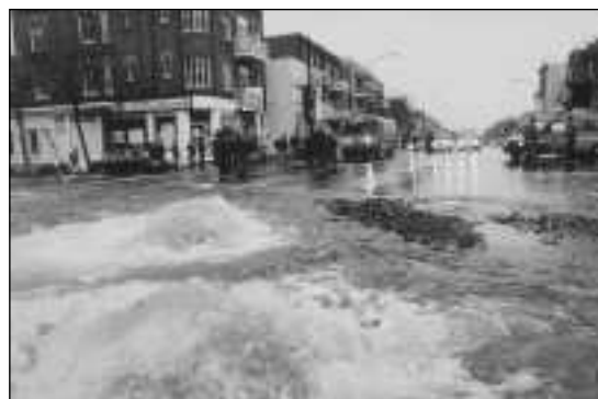
Figure 1. Les fuites d'eau ont pour effet d'endommager le réseau de distribution d'eau (érosion de l'assise des conduites, rupture des canalisations) et les fondations des routes ou des bâtiments.
