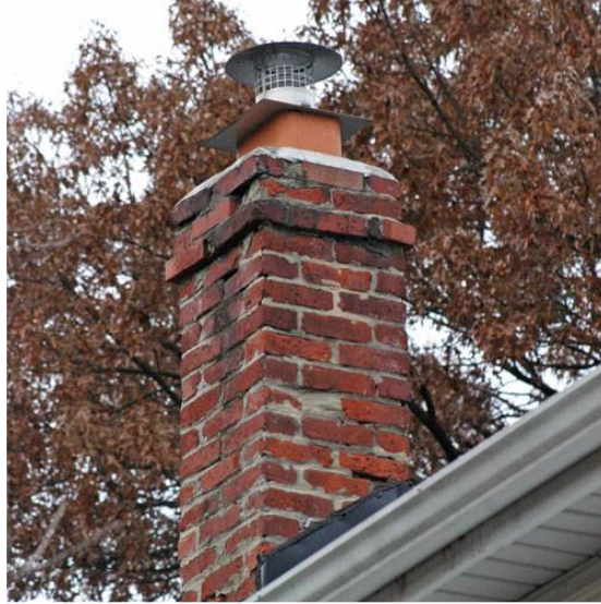
Figure 5.8 : Bâtiment OLB-P9 avec cheminée en maçonnerie non contreventée ( https://www.highschimney.com/this-old-chimney-part-1/ )
