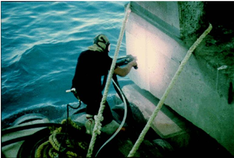
**Figure 3.** Pulvérisation à l'arc d'une couche de zinc sur un pilier de pont en béton dans les Keys de la Floride. Dans ce cas-ci, le zinc agit comme anode sacrificielle, mais ce métal est plus répandu dans les systèmes à courant appliqué. Trois systèmes à courant appliqué utilisant le zinc ont déjà été installés par le ministère des Transports de l'Ontario, à Toronto.
